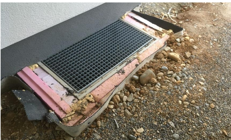
Abbildung 3: Isolierter Luftschacht
